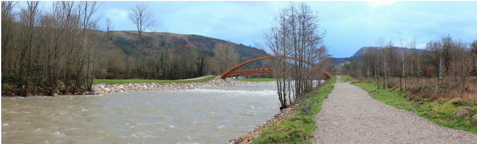
10 - CABEZÓN DE LA SAL 2013 – Puente sobre el Saja
